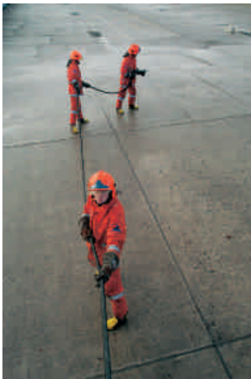
Nr. 1, nr. 2 og nr. 3 ved HT-udlægning
