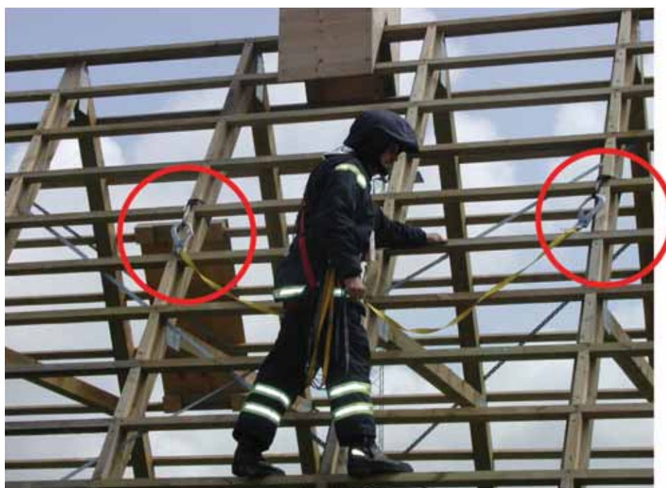
Punktvis forankring kan også give mulighed for at arbejde over en større flade
