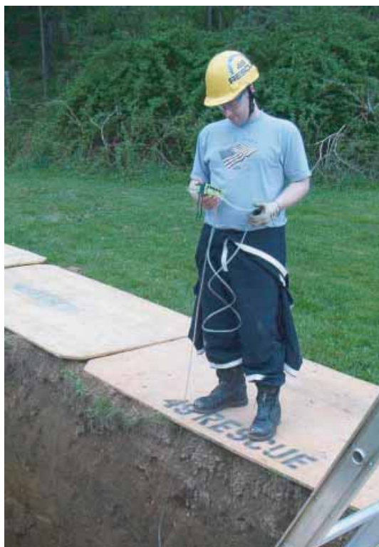
Der foretages løbende målinger for åndedrætsgifte. Personen står på sikringsplader omkring kanten af hullet
