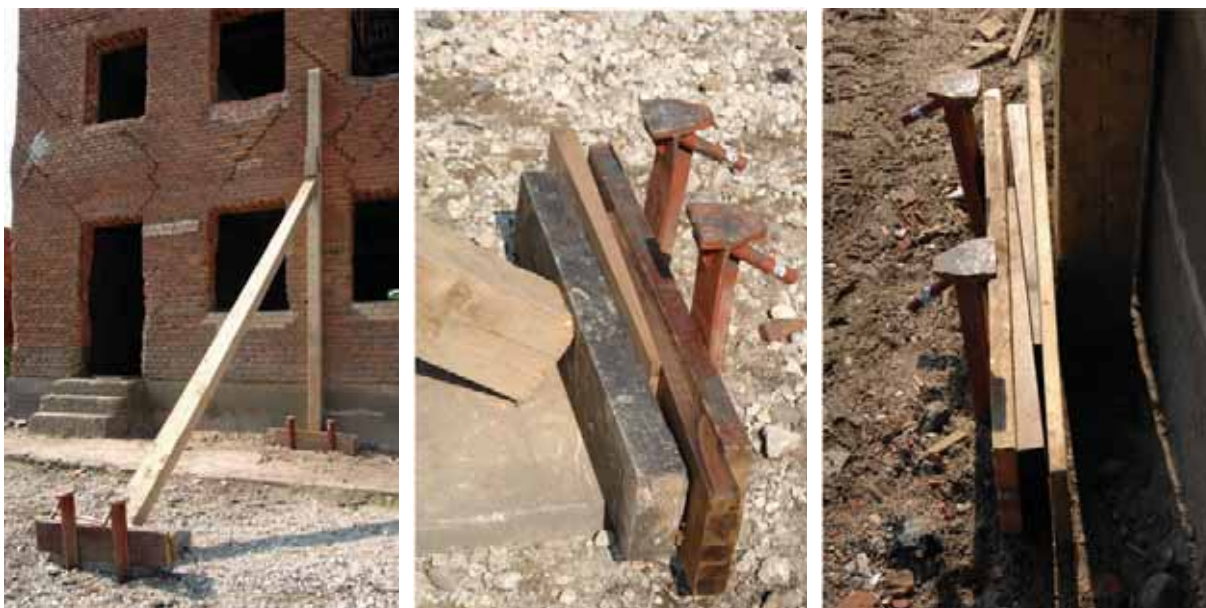
En skråafstivning med nærbilleder af henholdsvis støtten ved den skrå og den lodrette stiver
