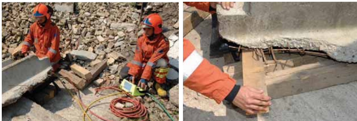
Løft med luftpudeløftere og opklodsning
