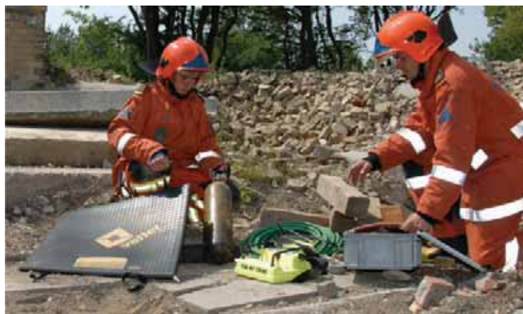
Luftpudeløfter med styrepult og luftslanger
