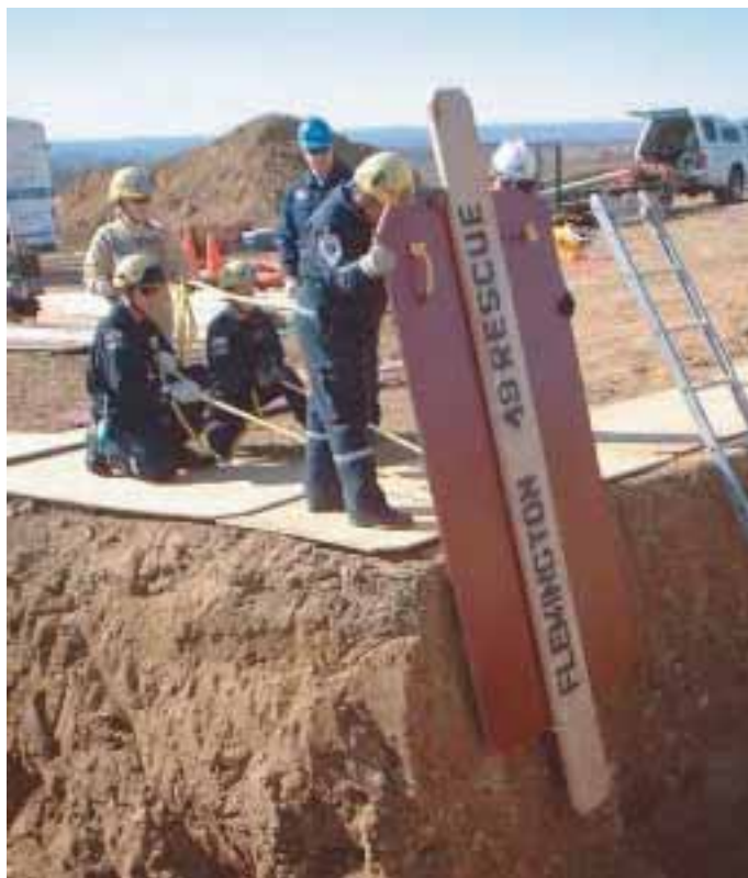
Redningsmandskabet sænker en plade ned i hullet, med stigen sat op som adgangsvej
